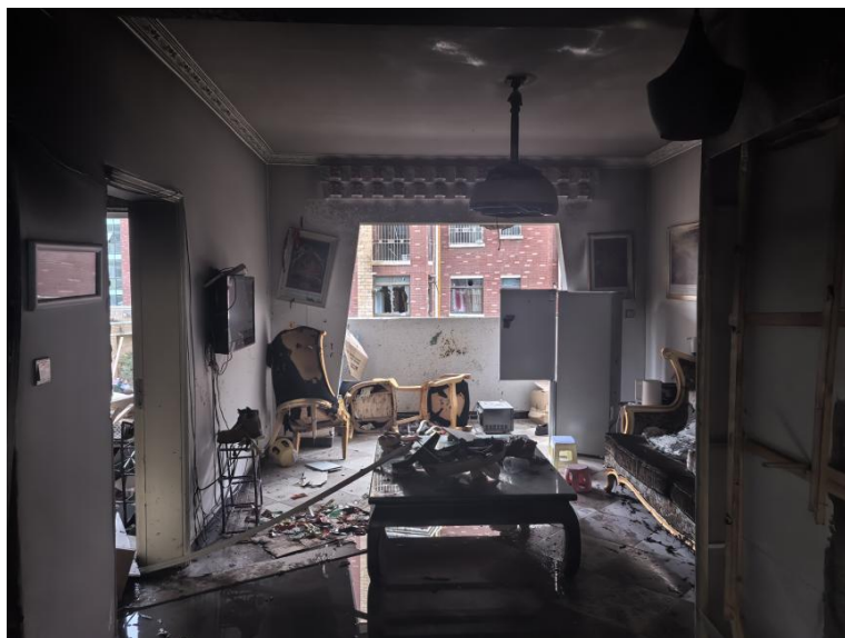
图 1-5 117 栋 1 单元 301 室客厅（面向南侧阳台方向）轰燃后现场照片
